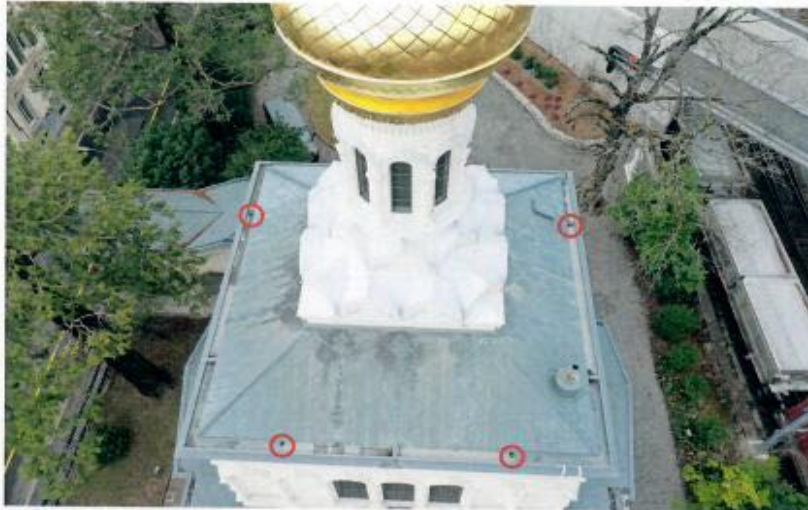
Toiture de la nef: position des naissances des descentes d'eaux pluviales.
